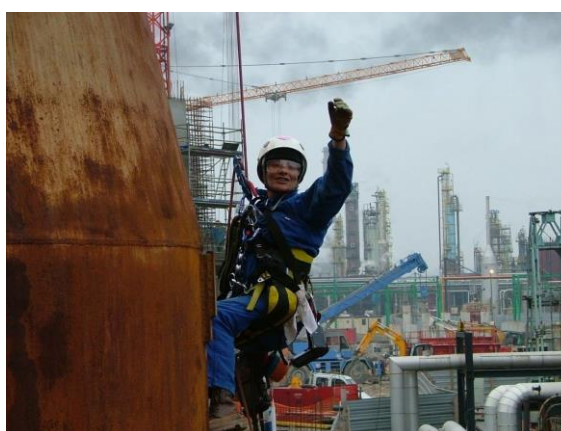
Inspection de l'épaisseur d'une cheminée par mesures ultrasons Raffinerie TOTAL le Havre (76)
